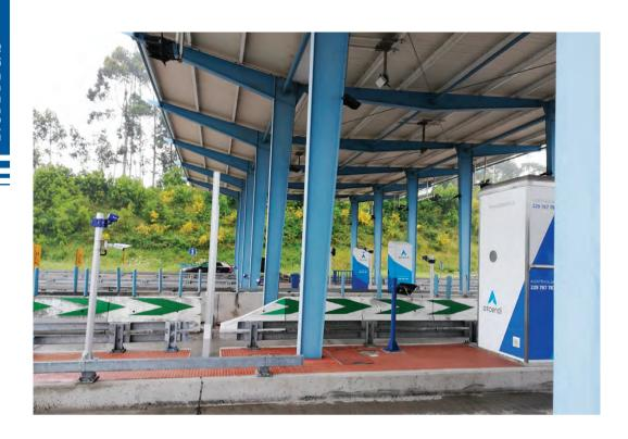
pées de caméras LAPI Tattile Basic, avant et arrière. Le nouveau système offre désormais une reconnaissance des plaques minéralogiques à grande vitesse pour le télépéage (ETC) manuel et automatique, jusqu'aux voies ETC rapides de premier niveau qui, gérées conjointement avec le système Via Verde (système de péage autoroutier avec utilisation du télépéage), permettent un prélèvement rapide des péages sans nécessiter l'arrêt du véhicule.
